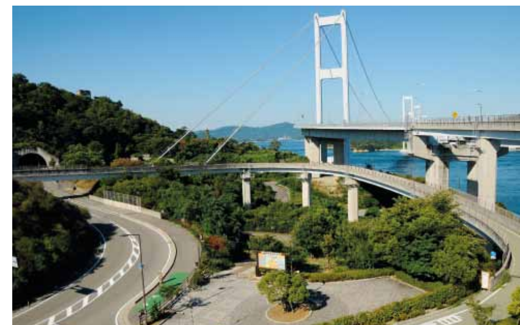
Nájezd na první most Kurushima-kaikyo Ohashi
